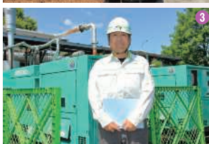
①敷地内にはチップ化された原料が山積みになっている ②チップ化されたバイオマス原料 ③同時稼働できる発電機は3機（計150kw）。現在、まだ全稼働はしていない ④高温でガスを抽出する熱分解炉（ロータリーキルン）
