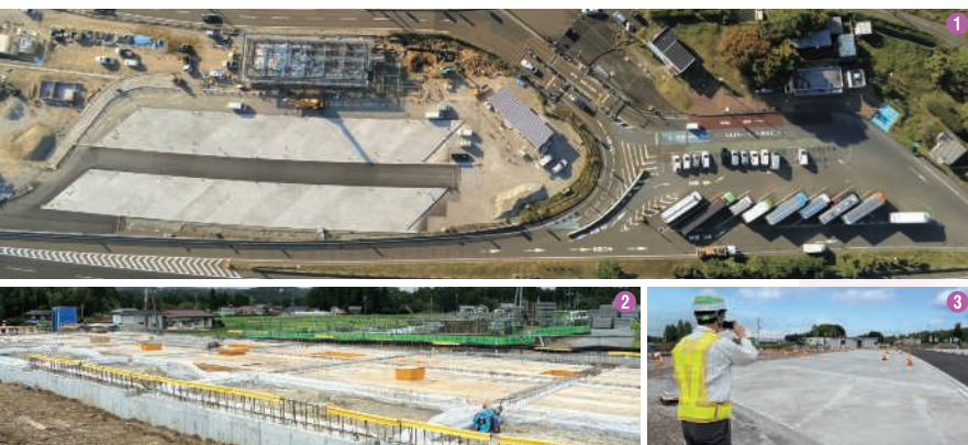
① 泉PA下り線（24年10月撮影）。右側が現在運営中の駐車マス。左側が拡幅工事エリアで、大型車駐車マスを大幅に増設 ② トイレ棟新築工事 ③ 工事進捗状況を確認 ④ 大型車駐車マスはコンクリートで舗装（24年9月実施）
