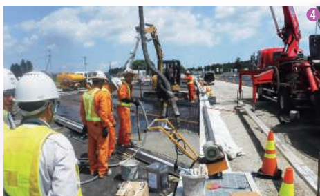
① 泉PA下り線（24年10月撮影）。右側が現在運営中の駐車マス。左側が拡幅工事エリアで、大型車駐車マスを大幅に増設 ② トイレ棟新築工事 ③ 工事進捗状況を確認 ④ 大型車駐車マスはコンクリートで舗装（24年9月実施）
